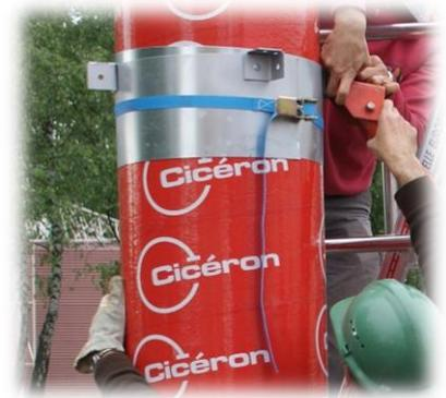
Elle se compose d'un feuillard galvanisé de 200 mm de large, d'une sangle avec tendeur à cliquet, et de trois ou quatre cornières percées (« oreilles »). Ces oreilles facilitent la fixation :
